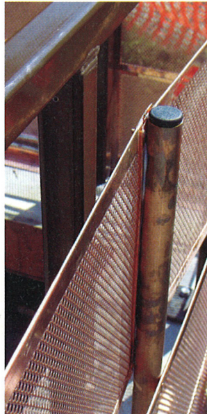
Detail der Terrassengeländer (Foto: Ernst Süsstrunk)
