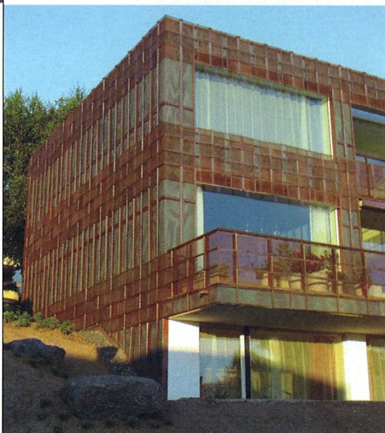
Ansicht der Fassade (Foto: Ernst Süsstrunk)
